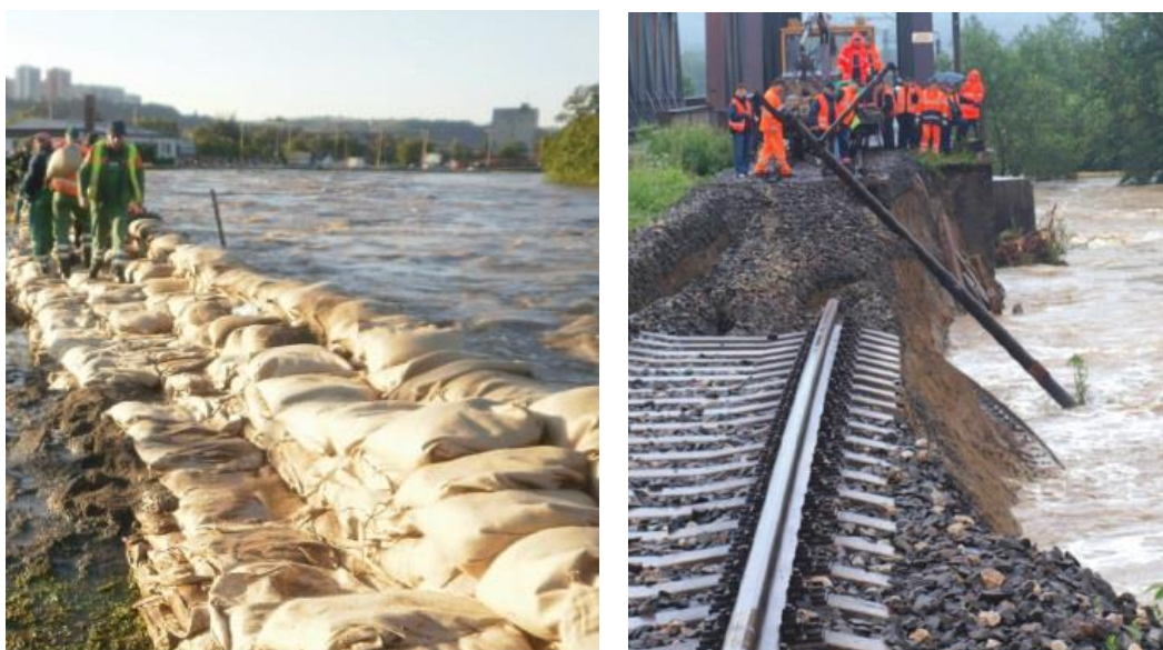
Fig.11.2: Trabajos de protección contra inundaciones y trabajos de rescate en inundaciones.
