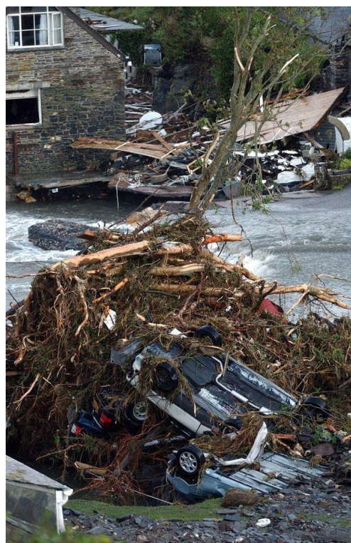
Fig.7.5: Daños causados por inundación repentina (Hards, 2018)
