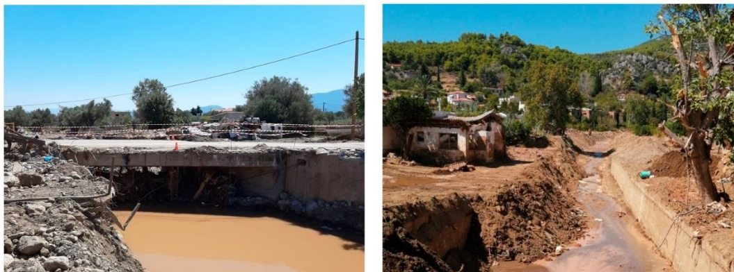
Fig.10.3: Consecuencias del derrumbamiento de escombros en un puente (Politika, isla de Eubea, Grecia); Consecuencias del derrumbamiento de escombros los edificios (Politika, isla de Eubea, Grecia) (Karkani et al., 2021).
