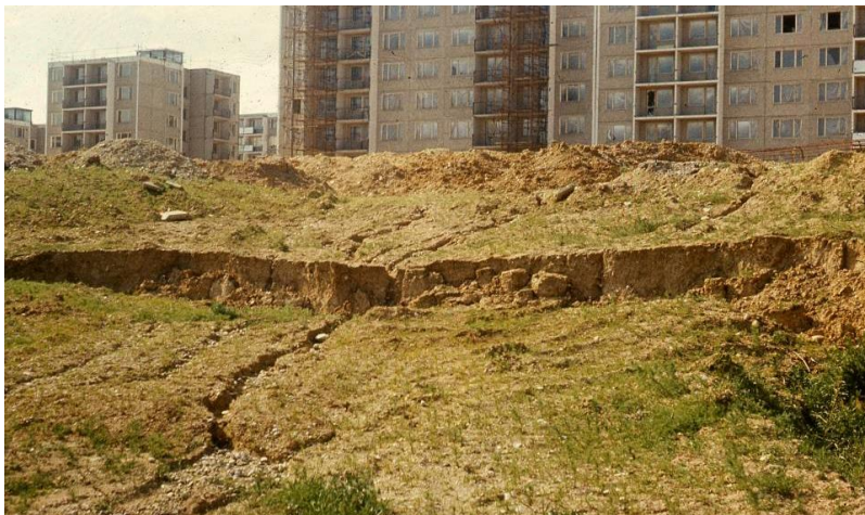
Šlaito įtrūkimas po nuošliaužos
