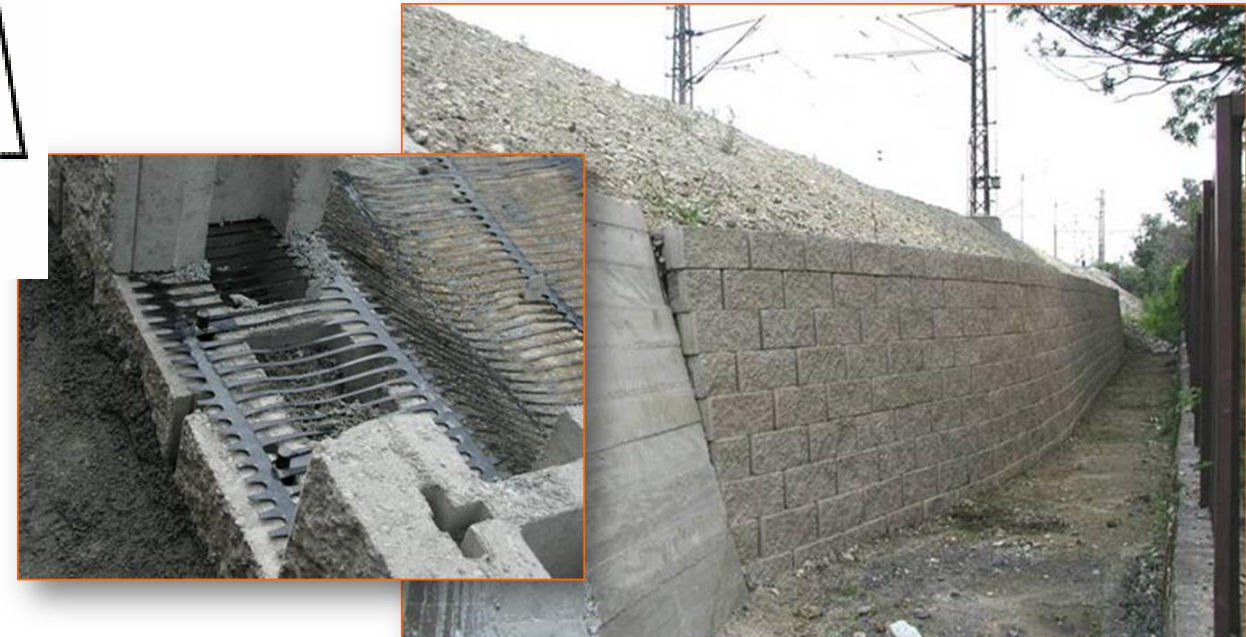
Šlaito sutvirtinimas su geosintetinėmis medžiagomis
