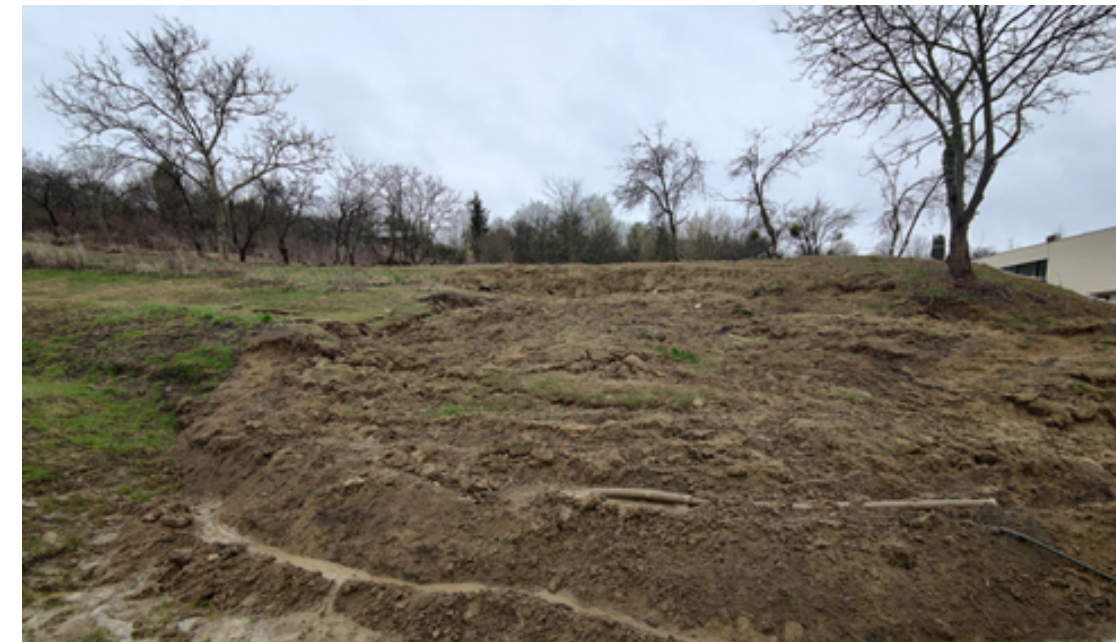
Deslizamiento de tierra causado por la lluvia
