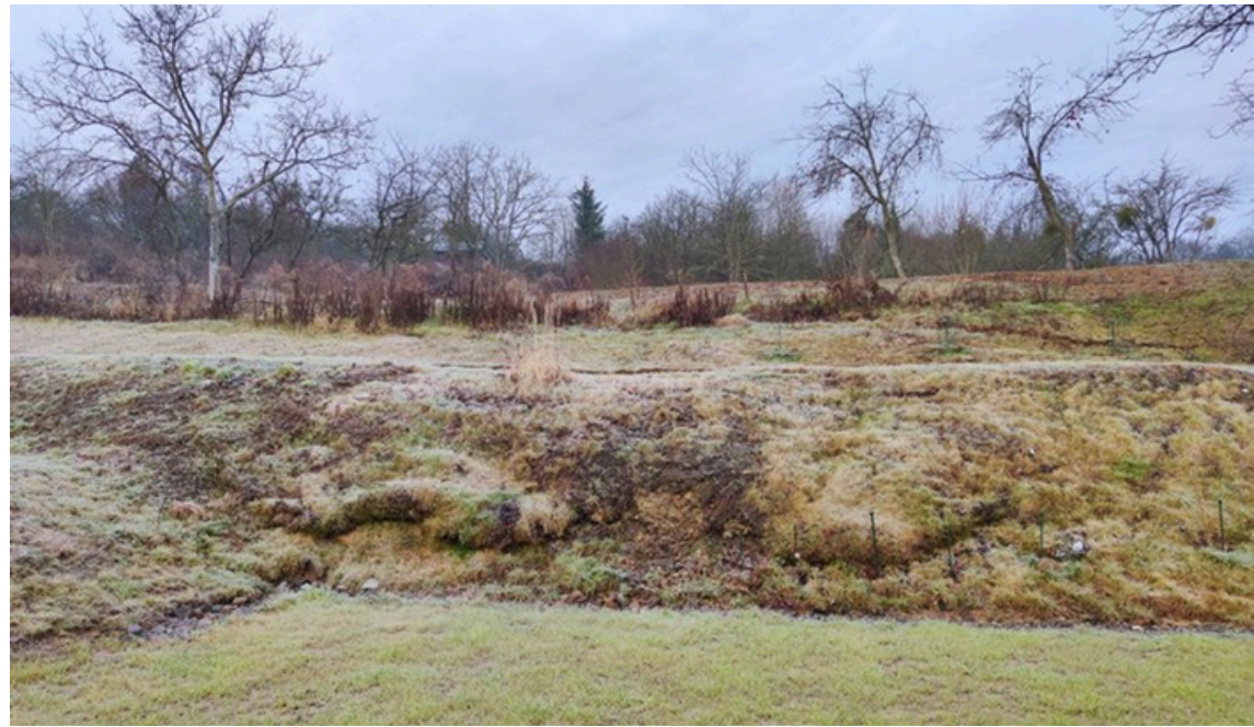
Manifestación inicial del deslizamiento de tierra
